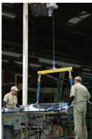
只用吊帶進行作業。
